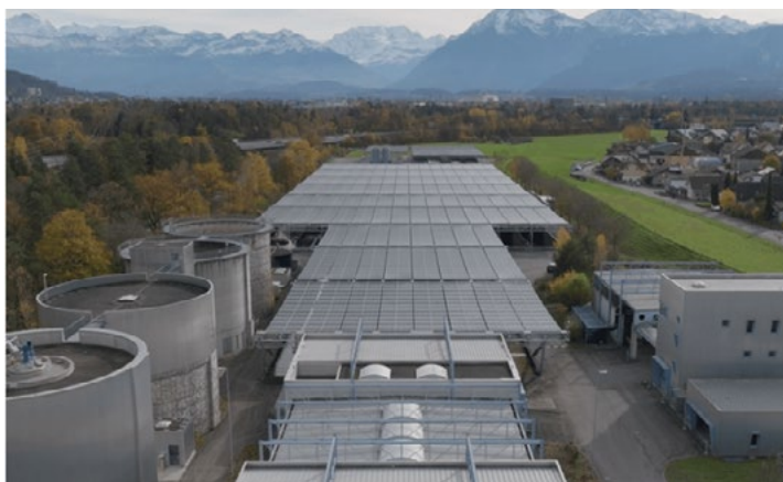
Il tetto fotovoltaico pieghevole inaugurato presso l'impianto di depurazione delle acque reflue di Uetendorf, nel cantone svizzero di Berna
