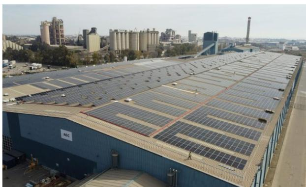
*Impianto fotovoltaico da 4.600 kW, realizzato in Spagna, in un sito industriale presso il porto di Sagunto (Valencia), dotato di 8.800 moduli fotovoltaici che coprono 48.400 metri quadrati di tetto, l'equivalente di 10 campi da calcio. Con una produzione annua di 7 GWh, questo progetto contribuirà a evitare l'emissione di oltre 800 tonnellate di CO2 equivalente all'anno.*
