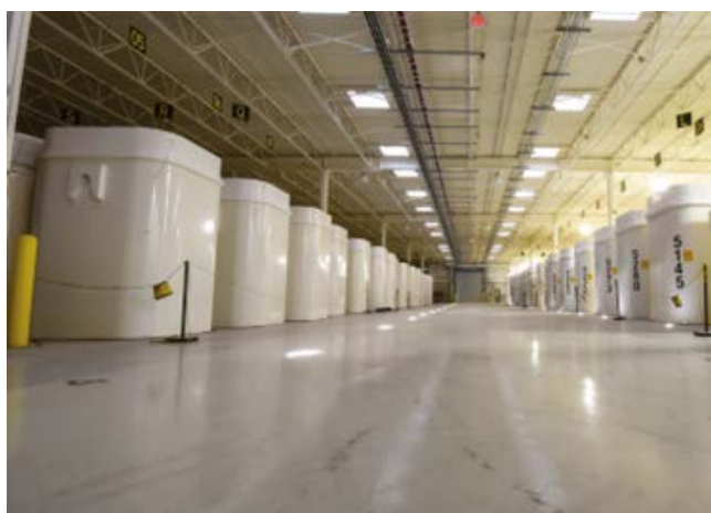
Contenitori in cemento per lo stoccaggio a secco di scorie nucleari. Foto: Nuclear Waste Management Organization (NWMO)
